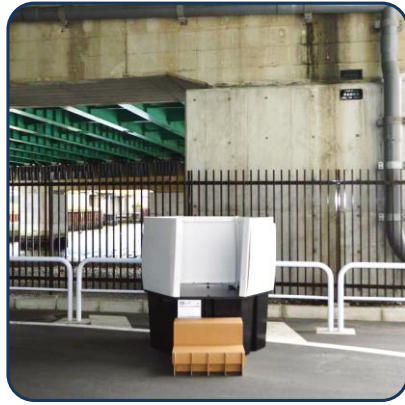
下壁パネル取付
