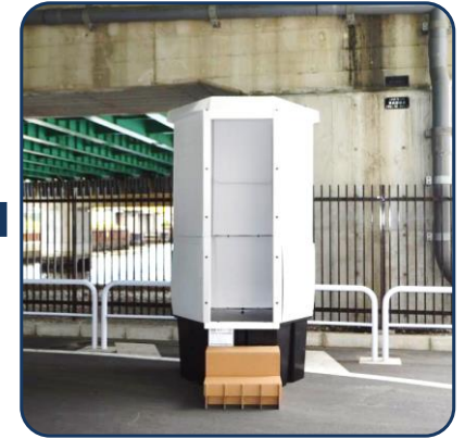
上壁パネル+屋根を取付
