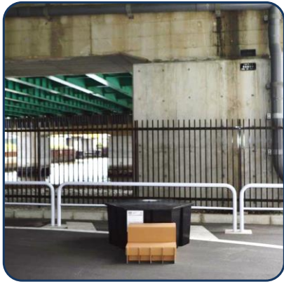
タンク・階段設置
