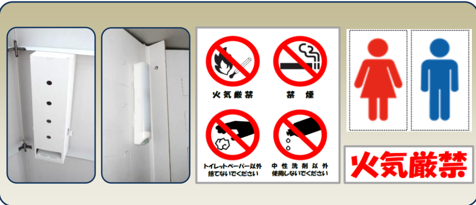
ペーパーホルダー・LED照明取付、シール貼り
